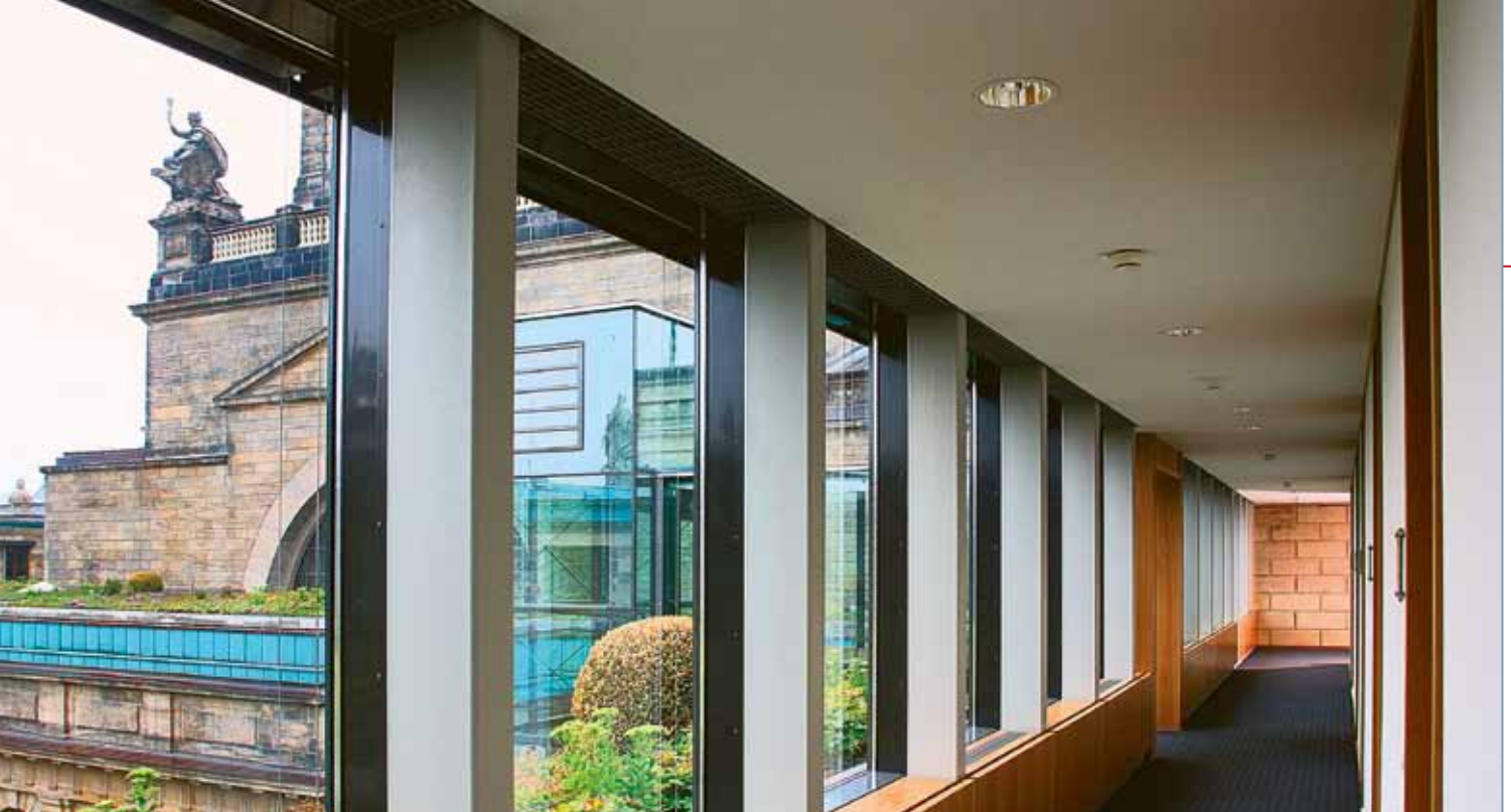
Zugang zum neuen Dachgeschoss des Bundesverwaltungsgerichts
