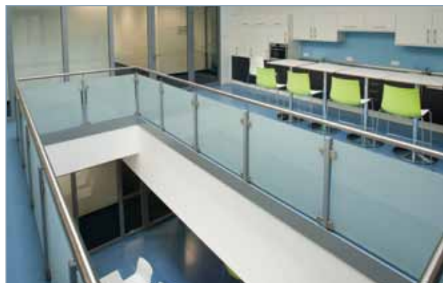
Blick in die Pausenräume nach dem Umbau
